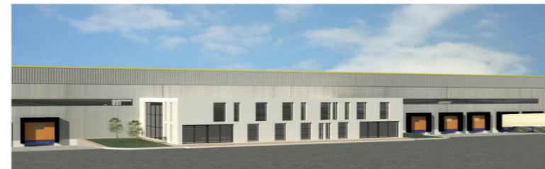
VUE SUR BUREAUX ENTREPÔT
